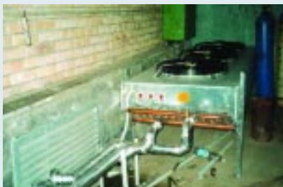
Градирня установлена снаружи возле дома
