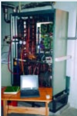
Компрессорно-конденсаторный агрегат PQRYP250YMF
