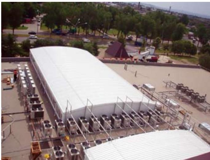
Типоразмер PEH-10 MYC/PUH-10 MYC 28,8 кВт был выбран как оптимальный по производительности: более мощные блоки для данного здания использовать было нецелесообразно, так как значительно усложнялась разводка воздухопроводов и усложнялась регулировка отдельных зон, а более маломощные требовали большего количества блоков, соответственно большего количества фреоновых проводов, на многие помещения требовалось более 1 кондиционера, что экономически нецелесообразно.
