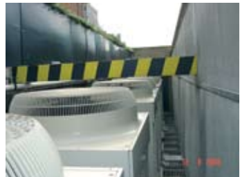
Внутри этого декоративного сооружения размещены наружные блоки
