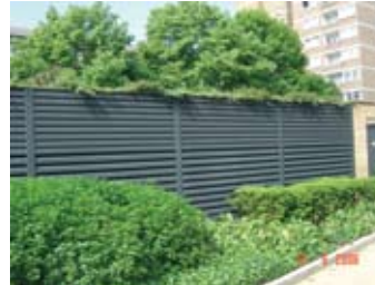
Внутри этого декоративного сооружения размещены наружные блоки
