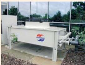
Такое высокое значение достигнуто благодаря новому роторному компрессору и двигателю с повышенной плотностью обмотки. Тепловые насосы нового поколения отличаются не только рекордной энергоэффективностью, но и самым низким на сегодня уровнем шума: 38 дБ(А) для модели с емкостью бака 370 литров. Внутренняя поверхность бака покрыта специальным составом, который на 15% снижает тепловые потери.
