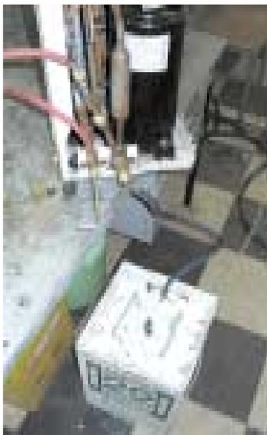
*Фото 2. Эвакуация хладагента с помощью откачивающего баллона*
