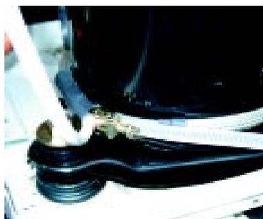
Рис. 2. Установленный картерный нагреватель
